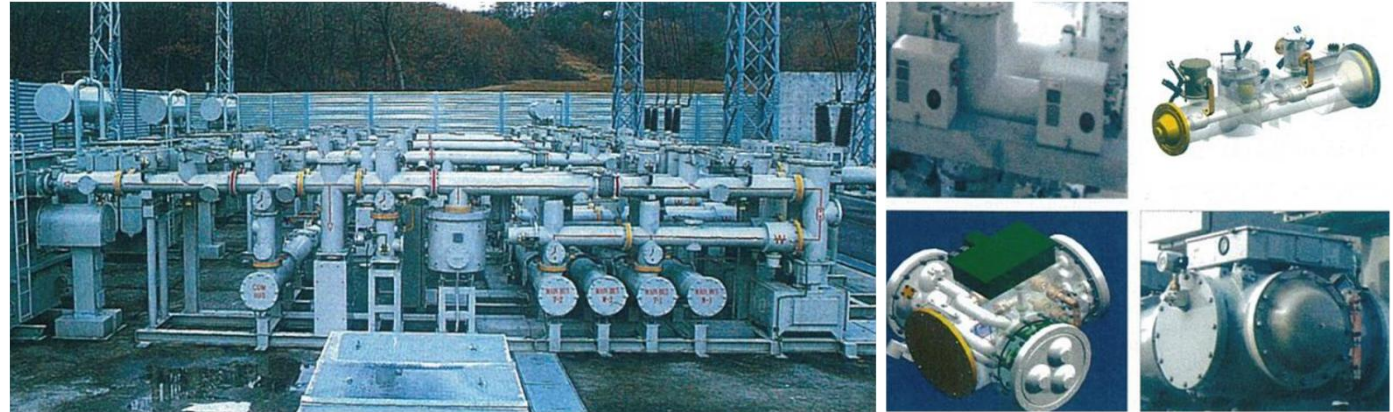
단로기 조작기(Disconnecting Switch)
